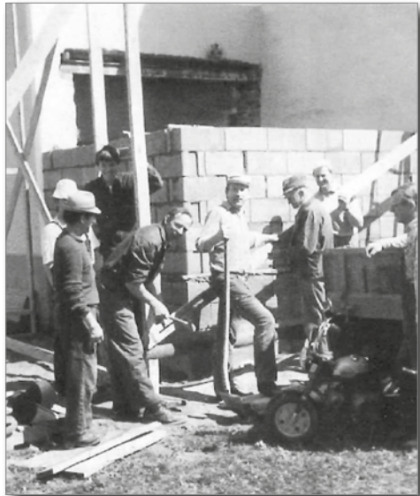
Kameraden unserer Wehr bei den Arbeiten, die im Zuge der Rüsthauserweiterung getätigt wurden
